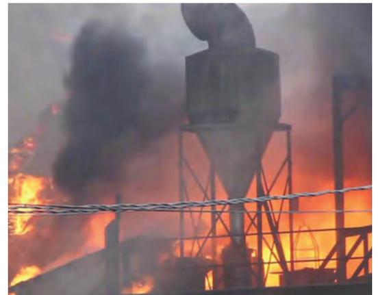
“Si se acumulan polvos combustibles, hay un riesgo de incendio y explosión en el colector, independientemente de la construcción del filtro”.
